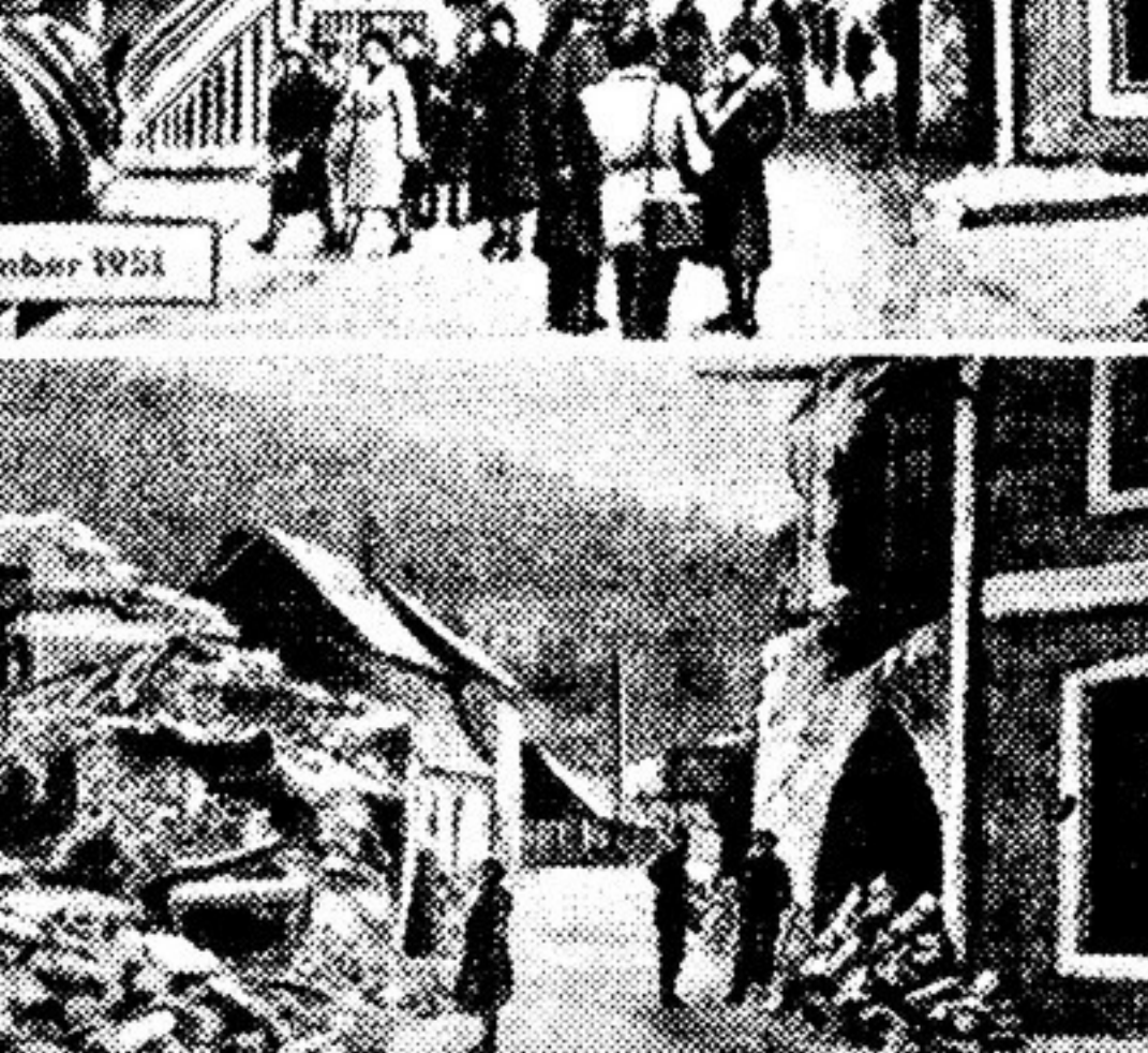
Деревня Хохенфельз до и после ее разрушения янки-окупантами.
